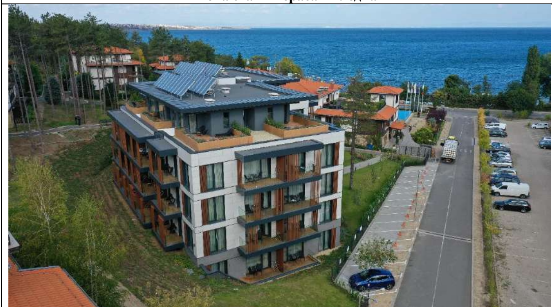
Фасада на сградата / околосградно пространство и гледка към морето
